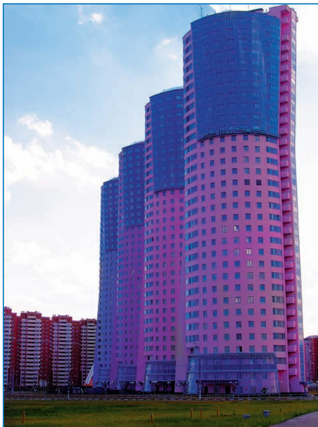
❖ ВЫСОТНЫЙ ЖИЛОЙ КОМПЛЕКС НА ХОДЫНСКОМ ПОЛЕ, г. МОСКВА. Система ПС и противодымной защиты на ПКП «Сфера 2001»
