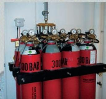
**Область применения:** ликвидация пожаров классов А, В и С, возгораний дерева, тканей, бумаги, резины, пластмасс, горючих жидкостей, масел, смазочных веществ, смол, лаков, горючих газов и электрооборудования.
