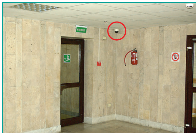
Рис. 4. Лифтовый холл жилого этажа
