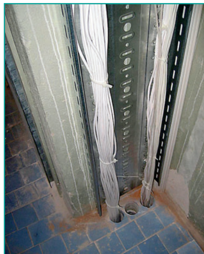
Рис. 10. Закладной проход. 2013 г.
