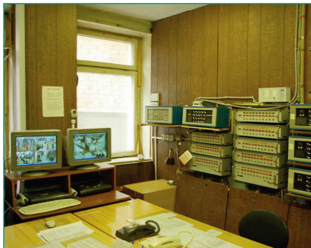
Рис. 8. Удаленное рабочее место «Центральный пульт системы ОПС»
